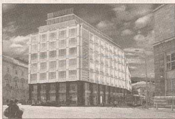
V októbri otvoria nové administratívne centrum na Štúrovej. V bývalej budove tlačiarň sa má podľa investora nachádzať najväčšia súvislá plocha kancelárií v strede mesta.
